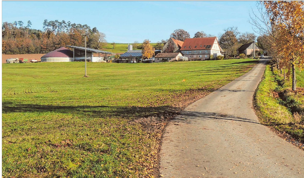
In Volkertsweiler soll ein einziger Breitbandnetz-Anschluss gelegt werden. Die Arbeiten dafür sollen auf Beschluss des Stadtrats über das Bundesförderprogramm bezuschusst werden. Foto: Peter Zumach
