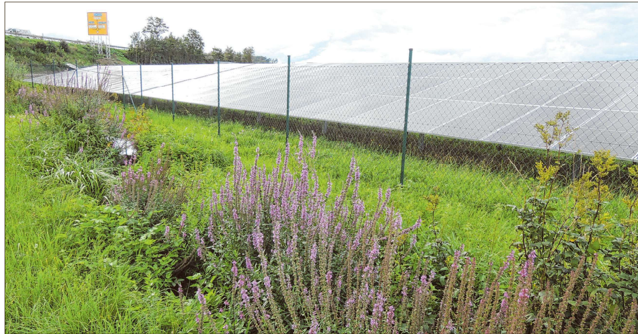
Das Solarfeld unweit des Rehau-Werks ist eine von drei Photovoltaik-Freiflächenanlagen der Stadtwerktochter nahKRAFT GmbH. Eine zweite entsteht aktuell bei der ehemaligen Deponie, die dritte ist bei der Ameisenbrücke geplant. Dazu kommen weitere Module auf Dächern. Foto: Peter Zumach
