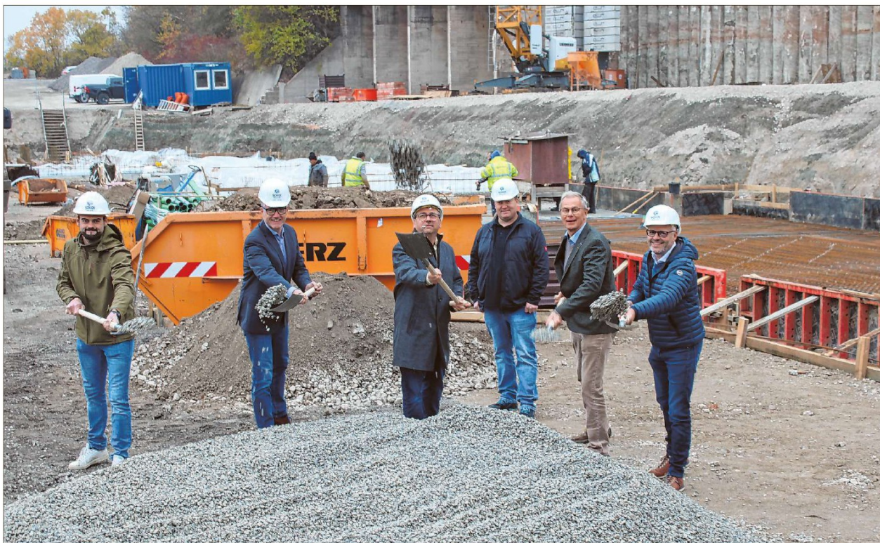
Beim symbolischen Spatenstich (von rechts): Investor Roland Kastner, der ehemalige Grundstückseigentümer Friedrich Herz, Alexander Strauß und Lothar Beckler von den Stadtwerken, Bürgermeister Patrick Ruh sowie Florian Iberl von der Baufirma. Foto: Herbert Dinkel
